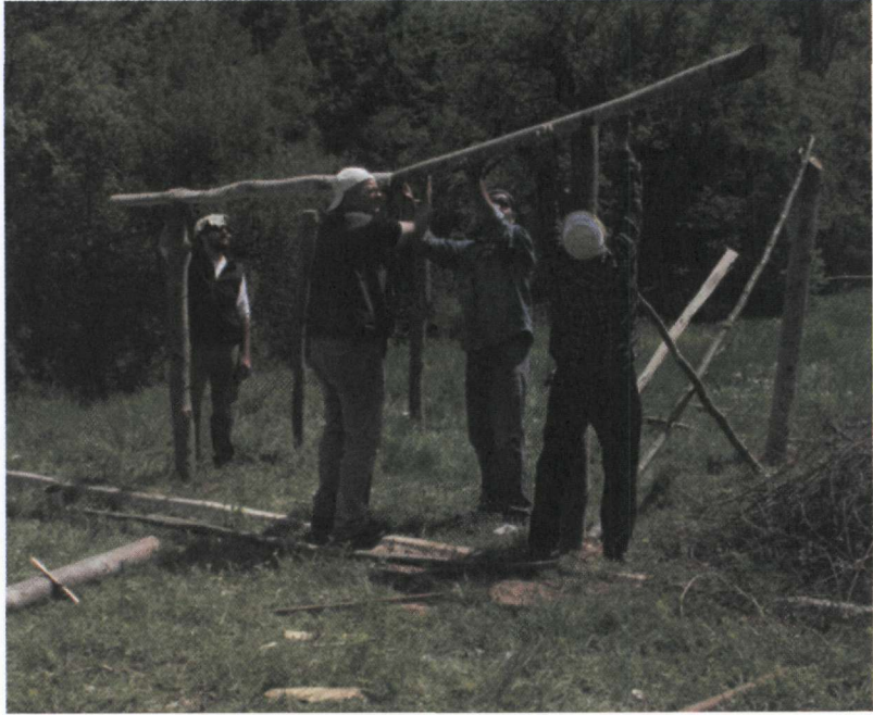
25. Τοποθέτηση των κάθετων στοιχείων από κορμούς οξιάς
