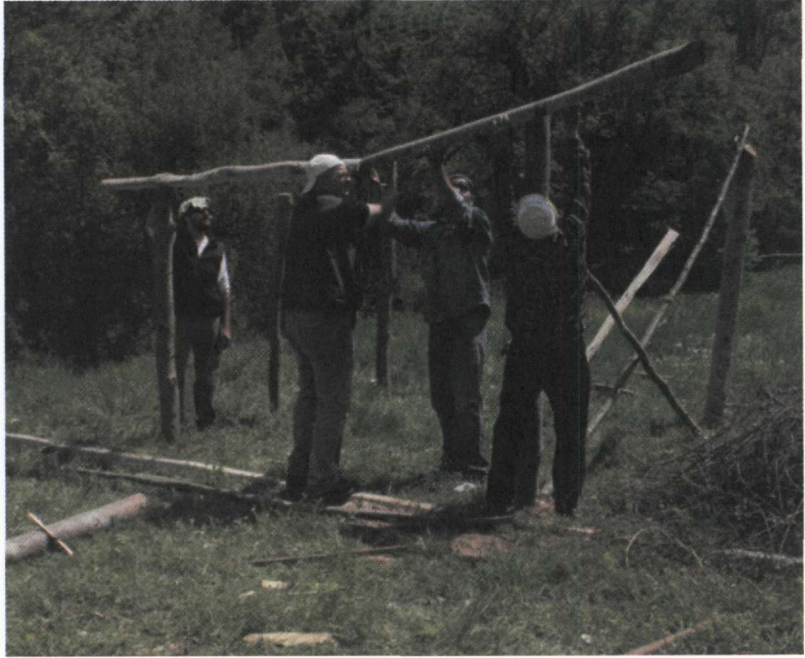
25. Τοποθέτηση των κάθετων στοιχείων από κορμούς οξιάς
