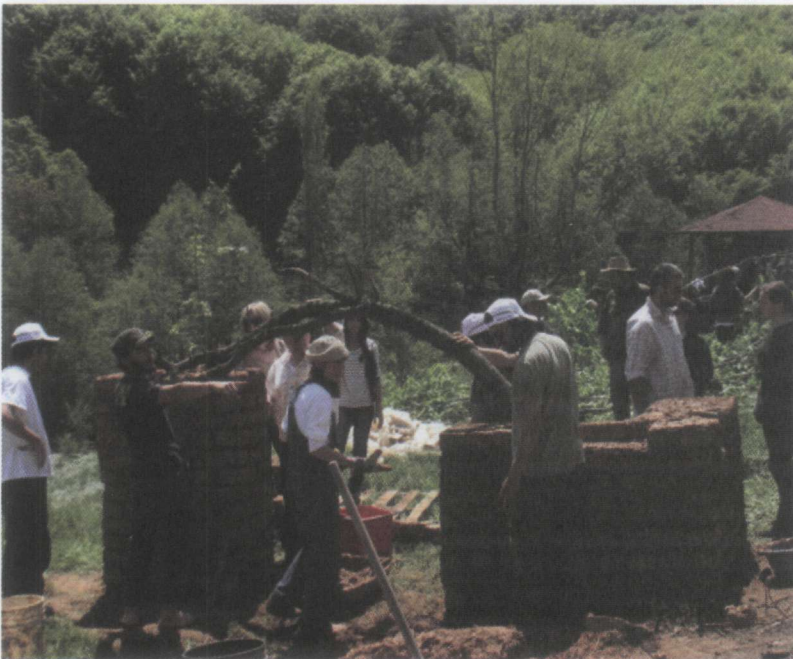
4. Το κτίσιμο του πορτονιού: ολοκληρώνοντας την κατασκευή
