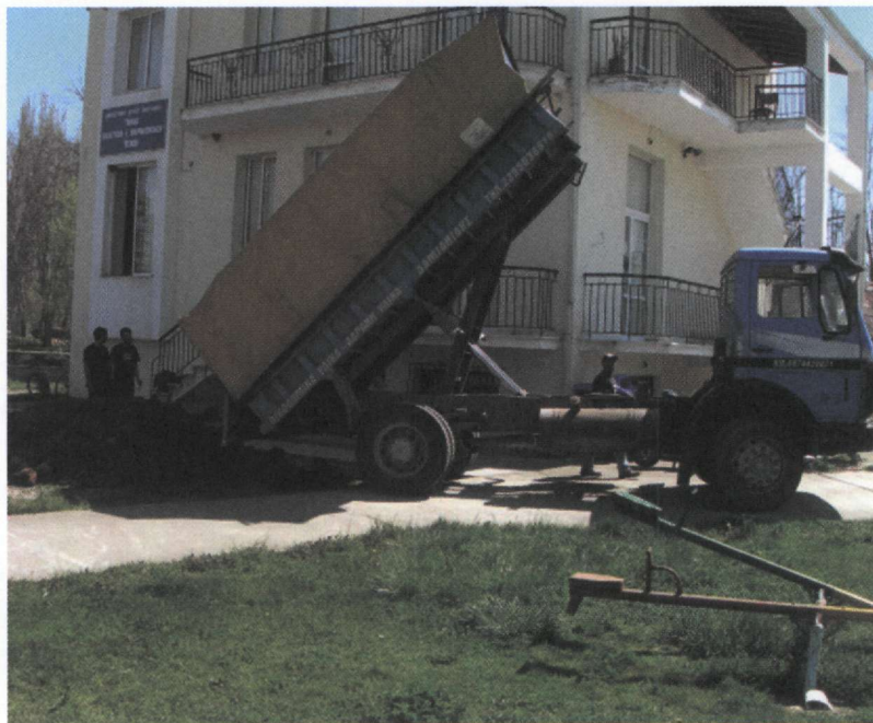
1. Η μεταφορά αργιλοχώματος στο Μεσσήσι
