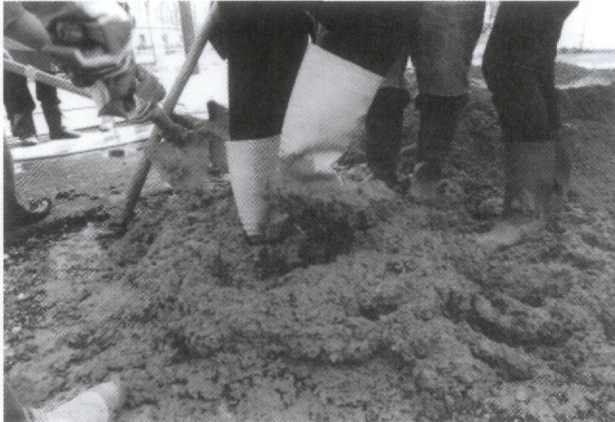
2. Ετοιμάζουμε το μείγμα του χώματος
