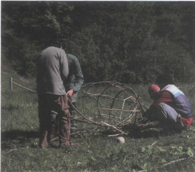
24. Σχηματίζοντας την κατασκευή από κλαδιά
