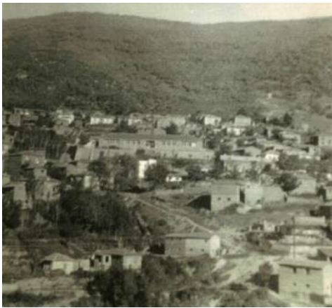
12. Το κτίριο του Δημοτικού Σχολείου, δεσπόζει στο κέντρο της κοινότητας. Νέα Δροσοπηγή 1958 (αγνώστου φωτογράφου παραχώρηση του Μορφωτικού Συλλόγου Δροσοπηγής « Η Πρόοδος»).
