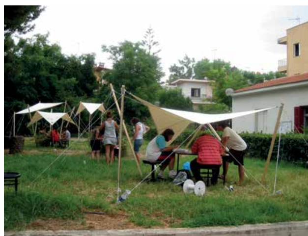
Εικ.8. Ανέγερση προηγμένων συστημάτων σε πραγματικό μέγεθος - προένταση και ισορροπία. (φωτογραφία: Ιάκωβος Ρήγος. Από το μάθημα «Ελαφρές Κατασκευές» στη Σχολή Αρχιτεκτόνων του Πολυτεχνείου Κρήτης, Επίκουρος Καθηγητής Ιάκωβος Ρήγος, 2008).
