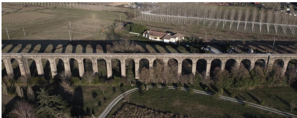
Fig. 1. Lucca, acquedotto del Nottolini, vista aerea del doppio condotto su archi, 2023.
