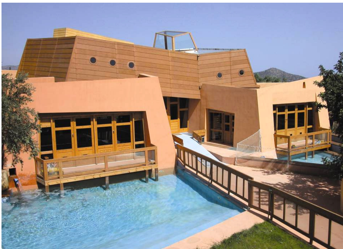
Εικόνα 2: «Κιβωτός» - ξύλινη κατασκευή από όγκους που αναδύθηκαν από το νερό
