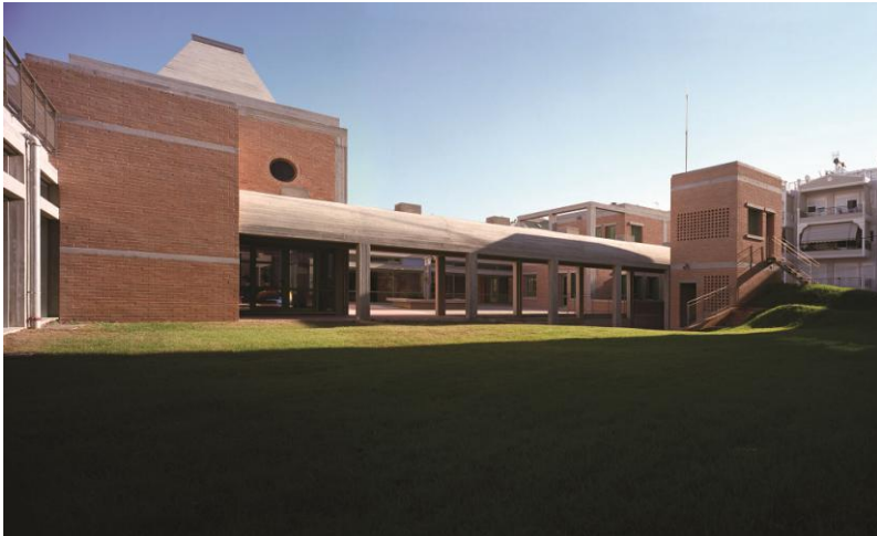
Εικόνα 9: Η φιλική σχέση του Παιδικού Σταθμού με την πόλη. Το αντιστικτικό παιχνίδι με αυτήν. Το νέο κτίριο σέβεται (δεν αποστρέφεται) την αστική αρχιτεκτονική των τυπικών σπιτιών όπου κατοικούν τα παιδιά, αλλά την συμπληρώνει ως νέα δυνατότητα. Η «Στοά», ο «Πύργος» και η φυσική «Γη» (ο «Κήπος» και ο «Γήλοφος»). Μια νέα (φιλική) αρχιτεκτονική παρέμβαση μέσα στον πυκνό υφιστάμενο αστικό ιστό. Το αρχέτυπο του –χτισμένου με τούβλα- τοίχου. (Το παιχνίδι των κύβων που πάντα αγαπούν να παίζουν τα παιδιά)
