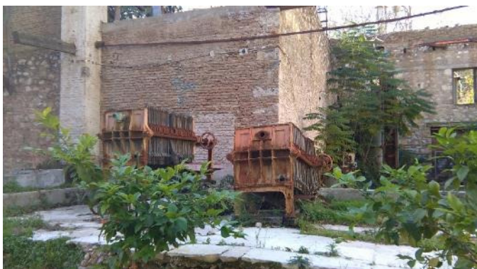
Εικόνα 4: Βιομηχανικά κατάλοιπα της ζυθοποιίας Μάμου, 11-2016. Συντεταγμένες λήψης 38.263860, 21.742053
