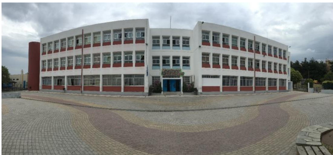
Εικόνα 1: Όψη του σχολείου
