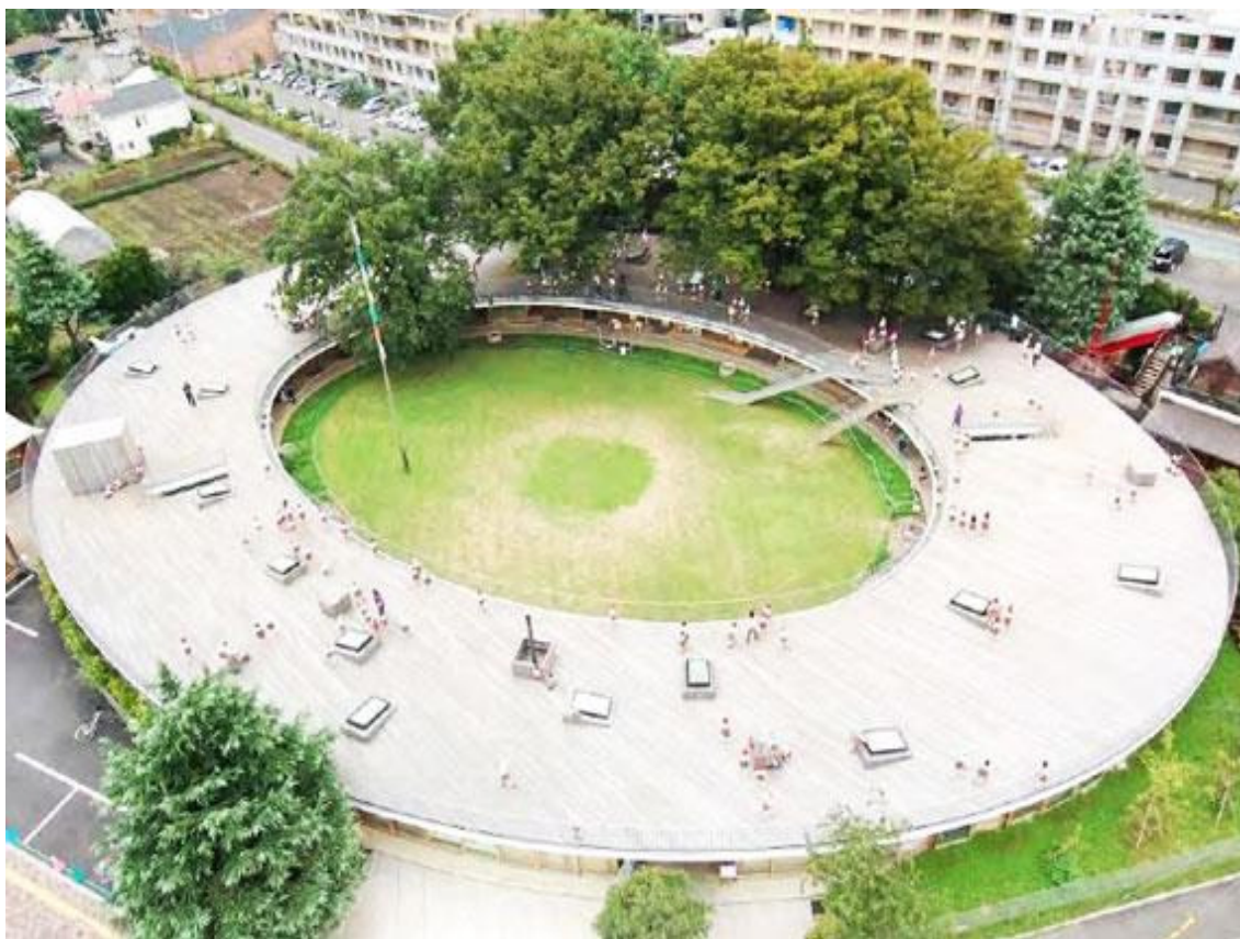
Εικόνα 1: Fuji Kindergarten , Τόκυο, Ιαπωνία 2007, Tezuka Architects, αεροφωτογραφία
