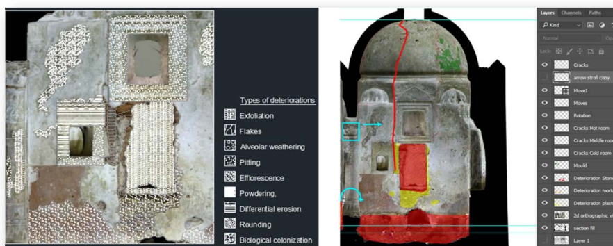
Εικόνα 11: Σχεδίαση και αποτύπωση των φθορών των μνημείων σε τρισδιάστατο περιβάλλον.
